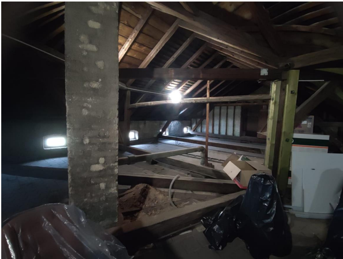
Obr. 2 – celkový pohled na krov směrem k západu
