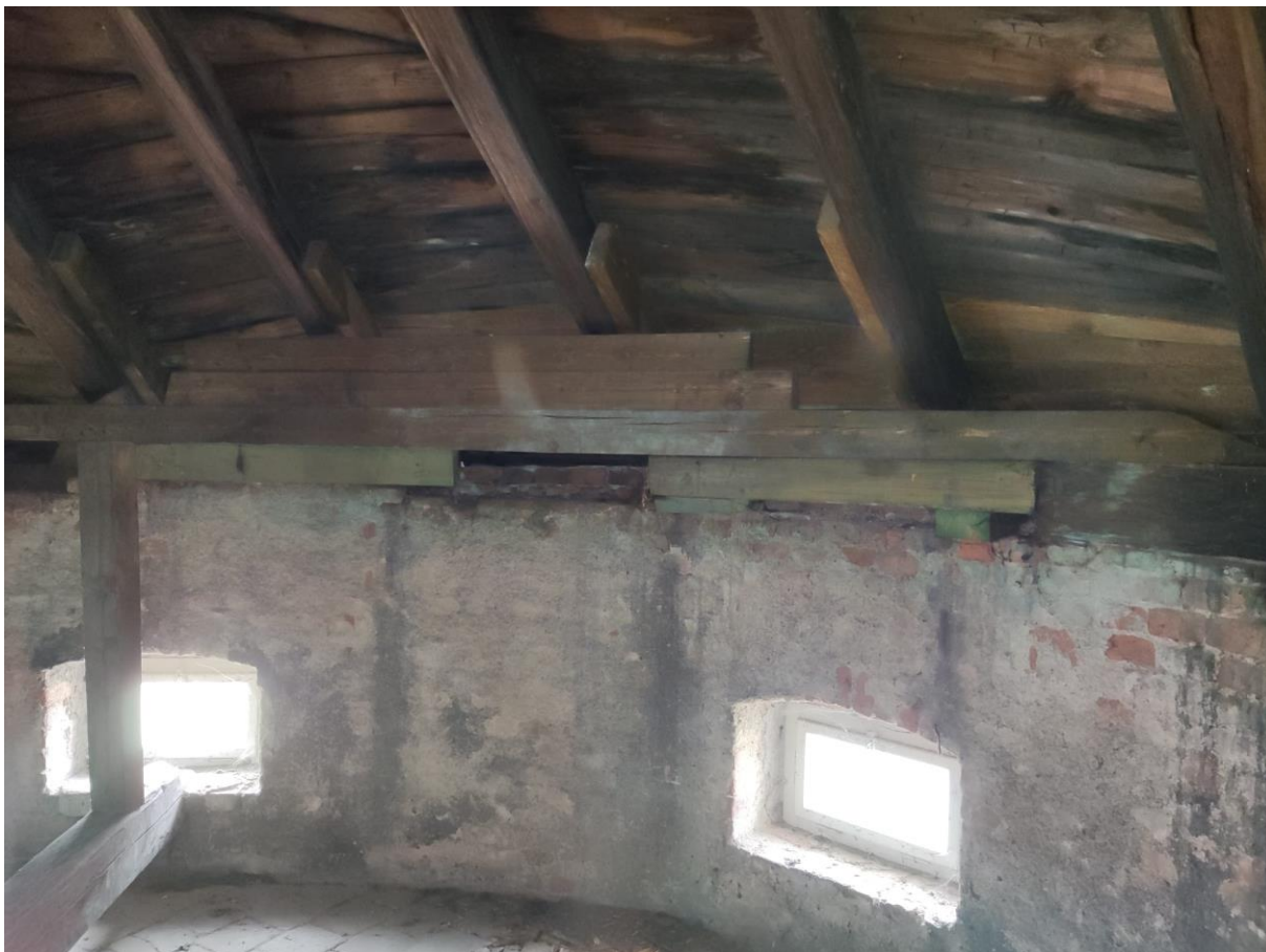
Obr. 7 – pohled na nadezdívku a krov obloukového průčelí
