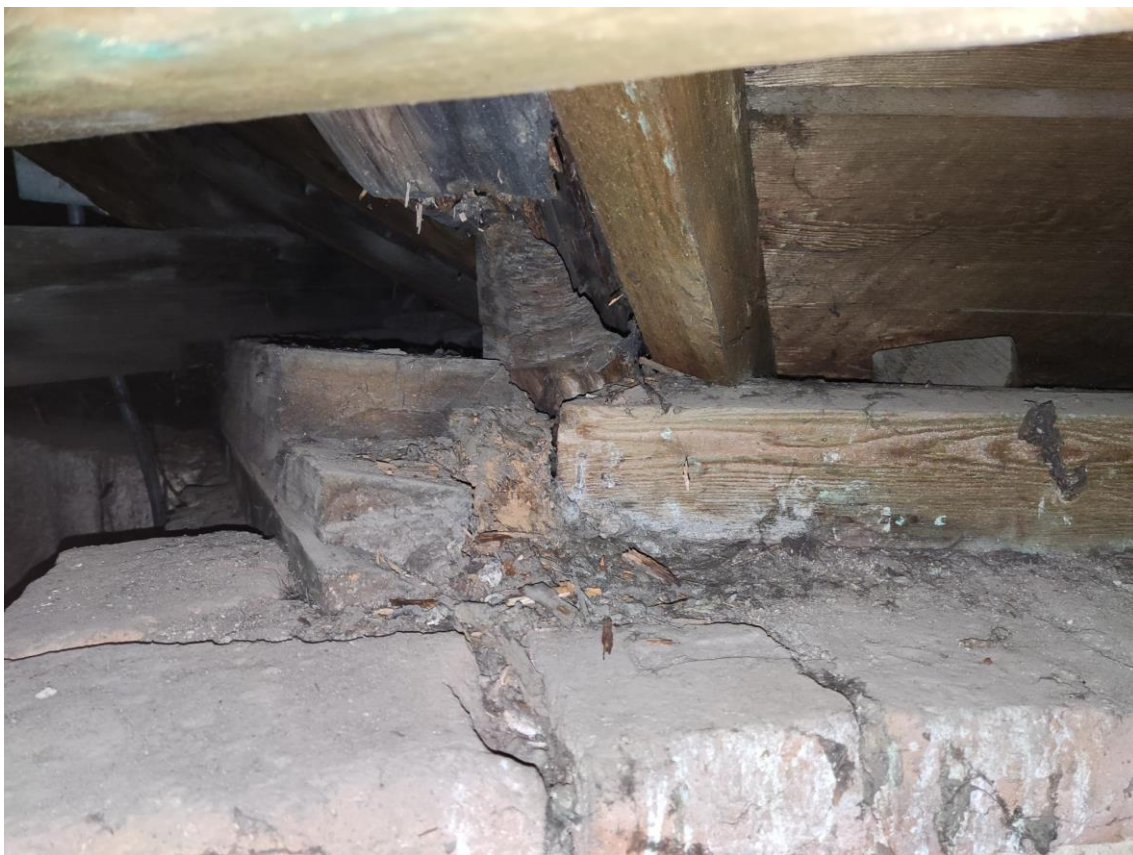
Obr. 8 – spoj pozednice a úžlabní krokve při severovýchodním koutu obloukového průčelí
