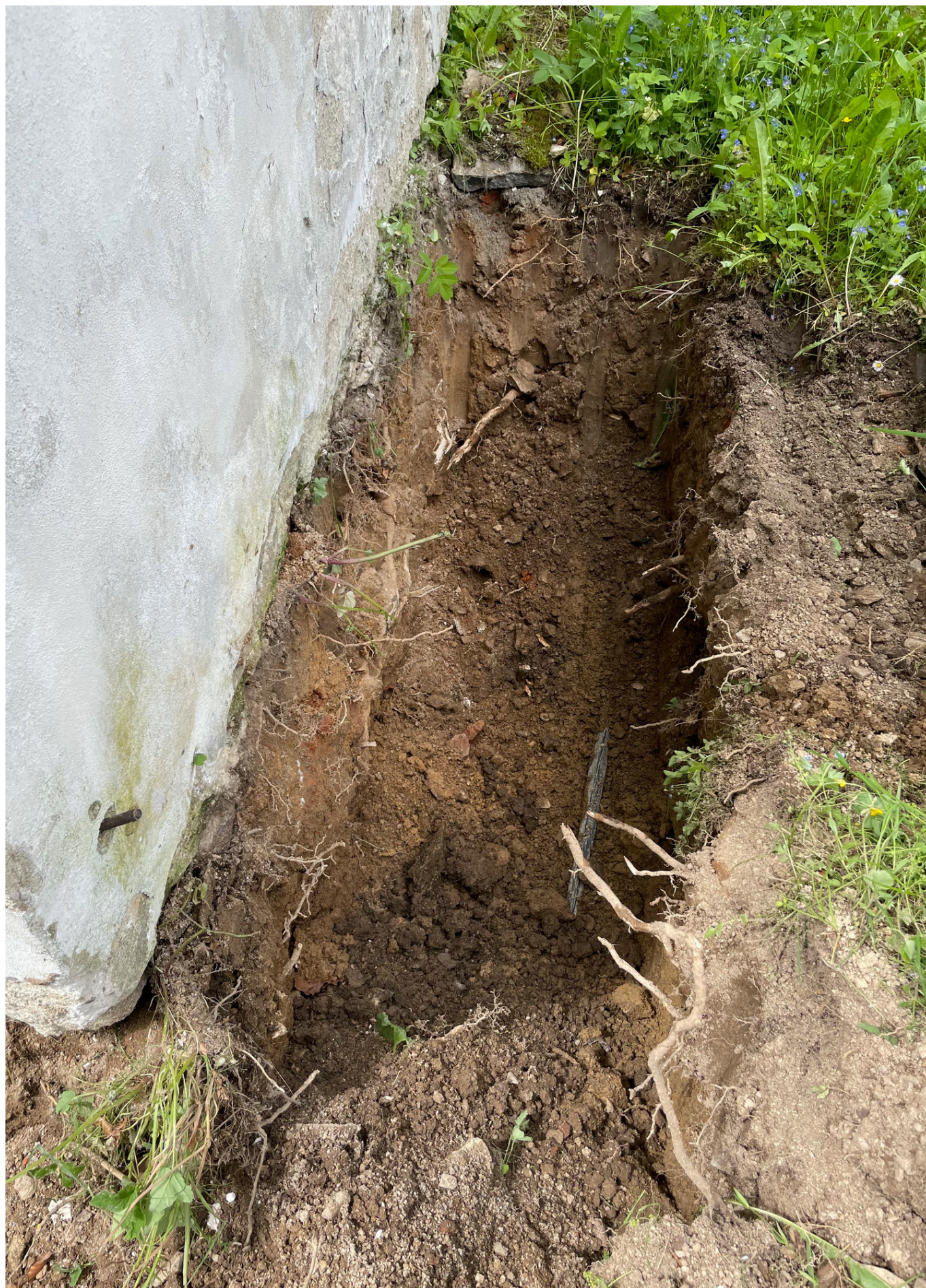
Sonda 4 - celkový pohled, vpravo kabel NN
