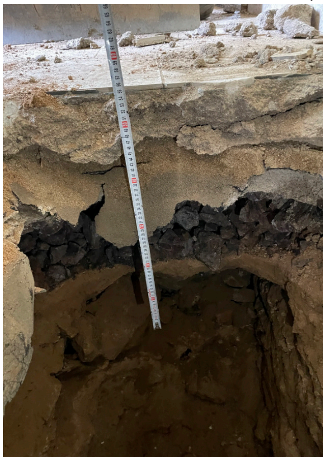
Sonda interiér 2 - detail skladby podlahy
