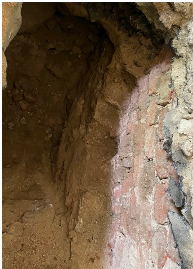
Sonda interiér 2 - celkový pohled a detail (vpravo cihelné zdivo na kamenném základu)
