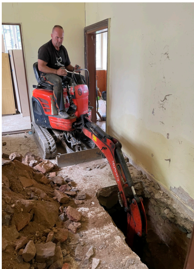
Sonda interiér 2 - celkový pohled a detail (vpravo cihelné zdivo na kamenném základu)
