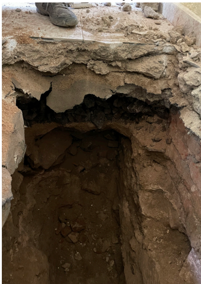
Sonda interiér 2 - detail skladby podlahy
