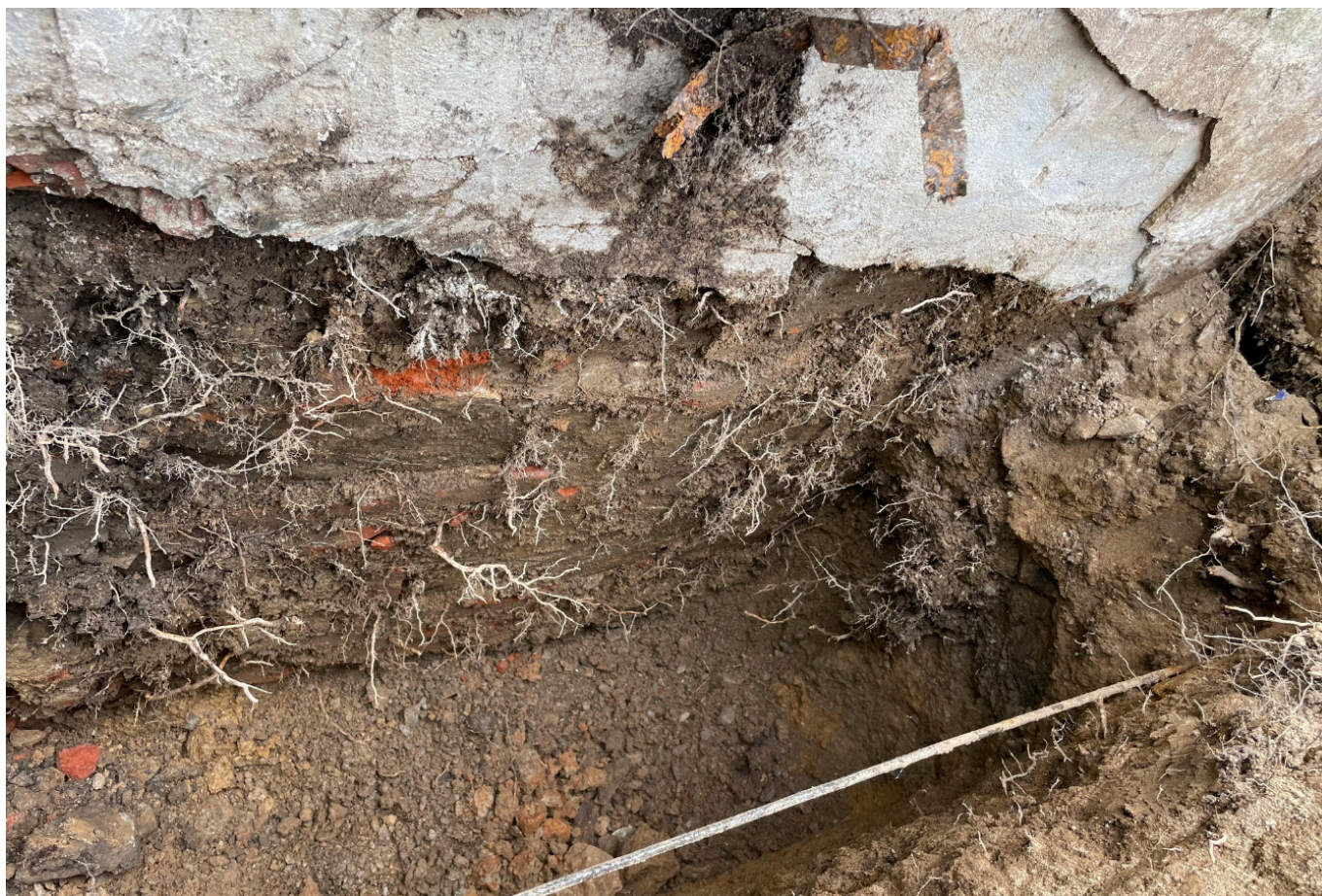
Sonda 5 - detail základového zdiva z lomového kamene
