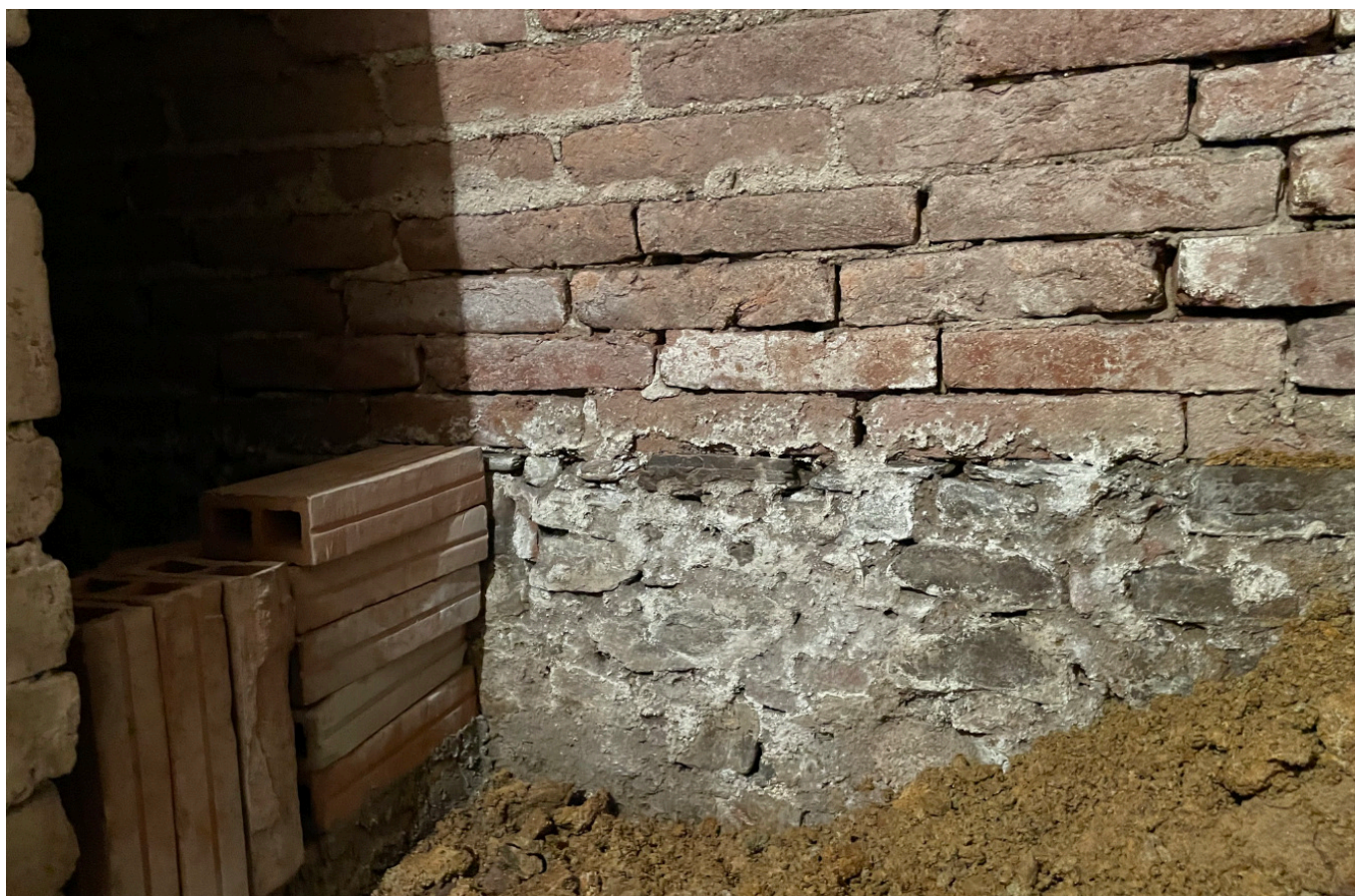
Pohled na nasazení zdiva klenby na základ. Základová spára je na úrovni podlahy sklepa.
