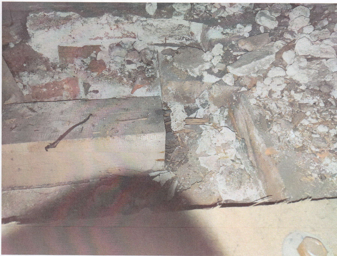
Obr. 8 – vyřezaná pozednice a zasypaná pozednice s destruovaným zhlavím
