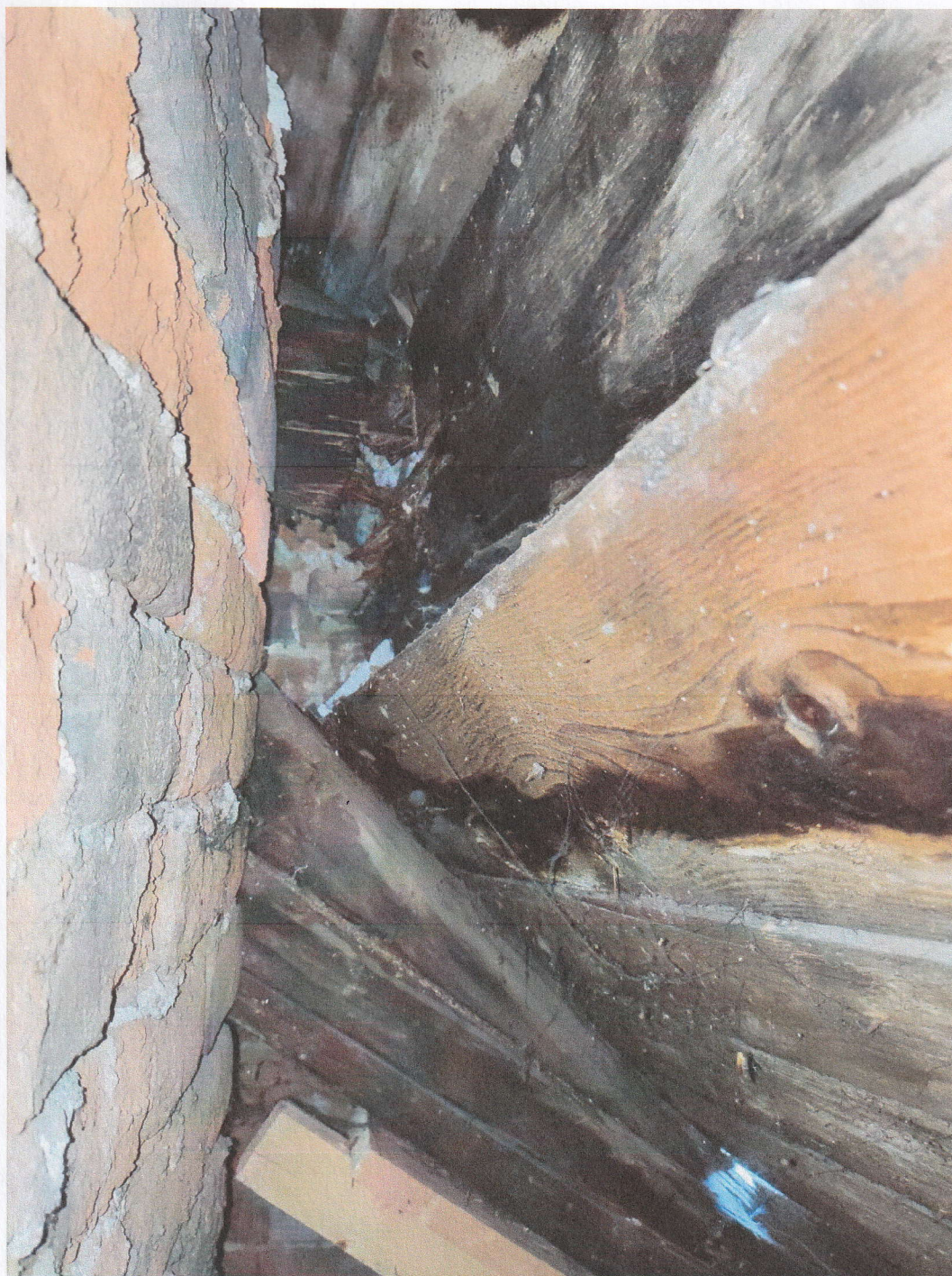
Obr. 7 – spoj vaznice a hambálku v severozápadním koutu krovu – místo odběru vzorku
