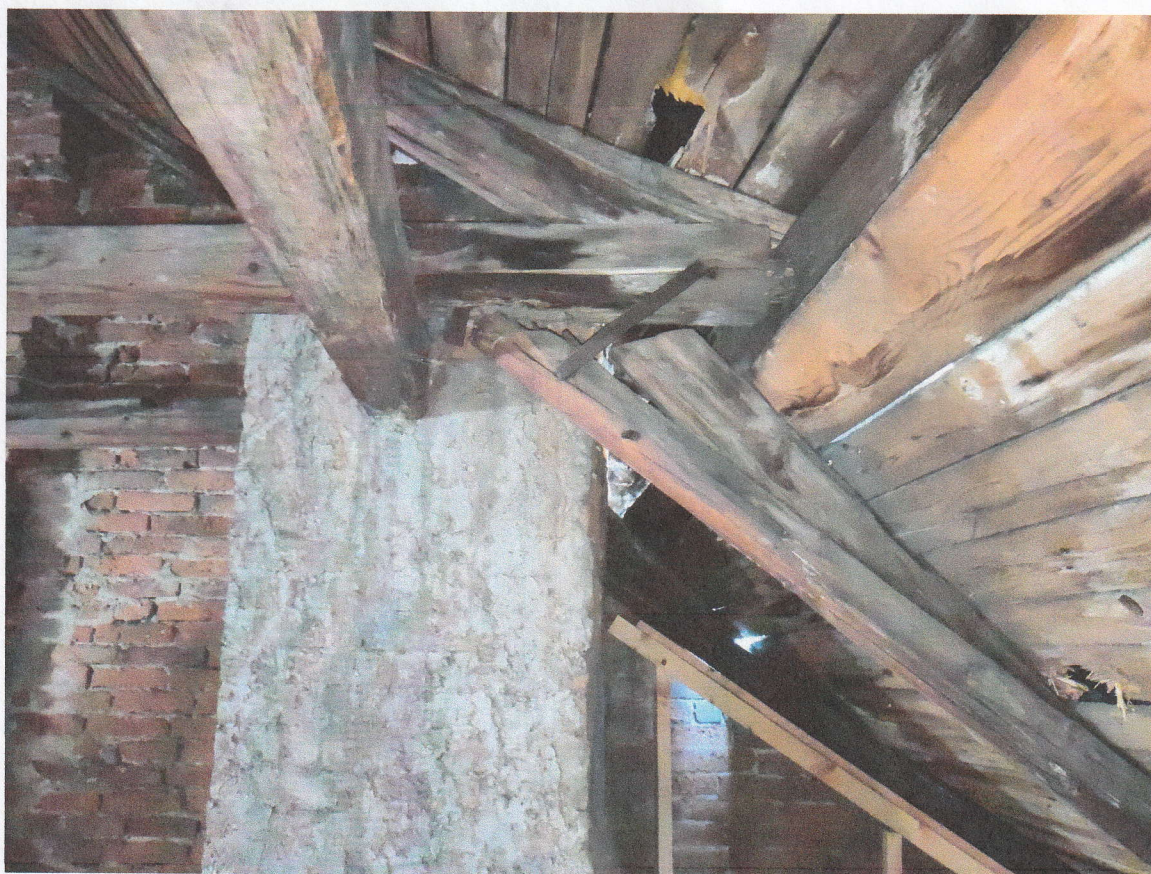
Obr. 9 – rozvolněný spoj krokve a hambálku při západním komíně
