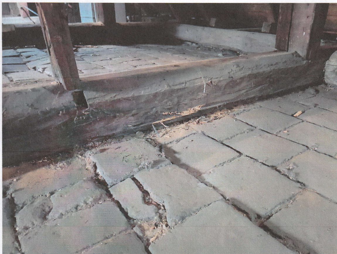
Obr. 4 – vazný trám osy plné vazby 4 napadený dřevokazným hmyzem
