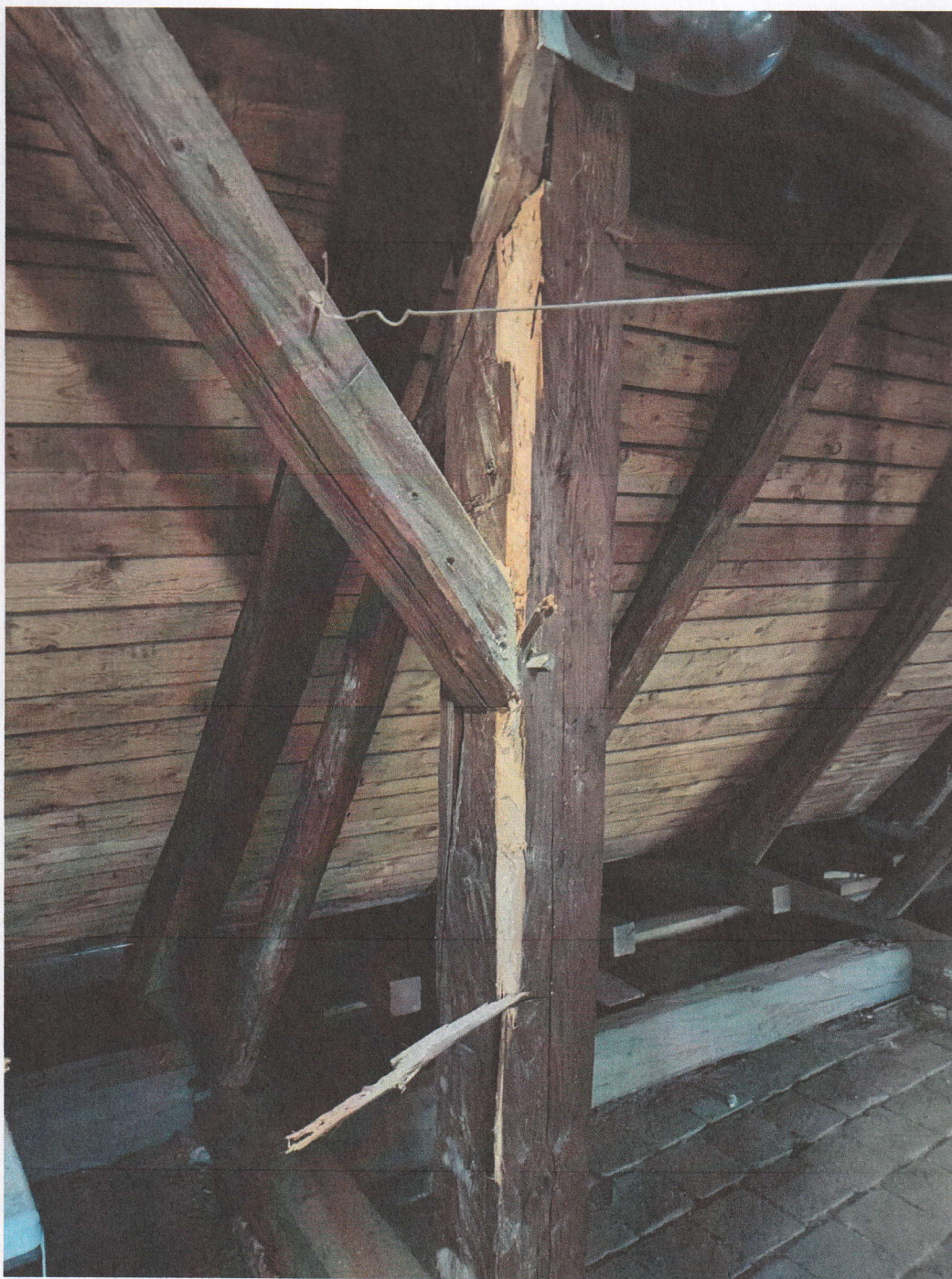
Obr. 6 – sloupek osy plné vazby 3 napadený dřevokazným hmyzem
