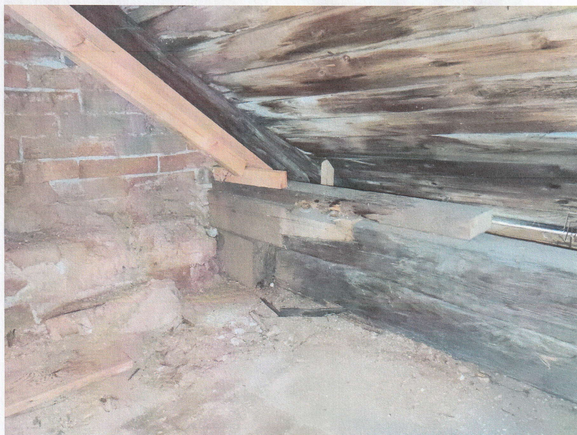
Obr. 5 – napadená pozednice a krokev s příložkou v severozápadním koutě krovu
