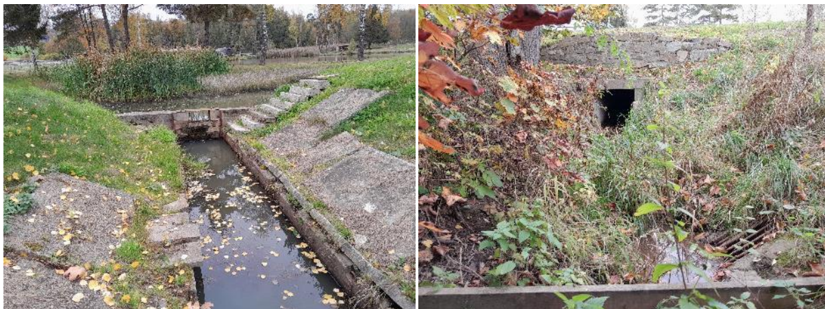
Obrázek 95 Stavidlem zadržovaná voda z přepadu rybníka nad křížením s komunikací (vlevo), pohled na lokalitu pod komunikací (vpravo)
