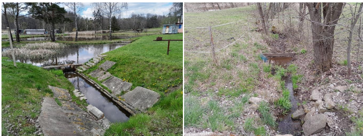
Obrázek 96 Stavidlem zadržovaná voda z přepadu rybníka nad křížením s komunikací (vlevo), pohled na lokalitu pod komunikací (vpravo)
