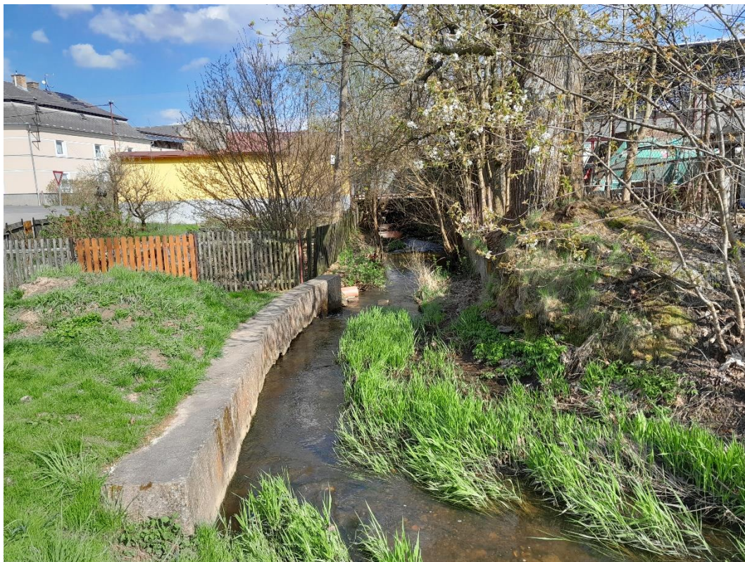
Obrázek 85 Pohled na lokalitu v místě přemostění, levý břeh je opevněn do betonové zídky
